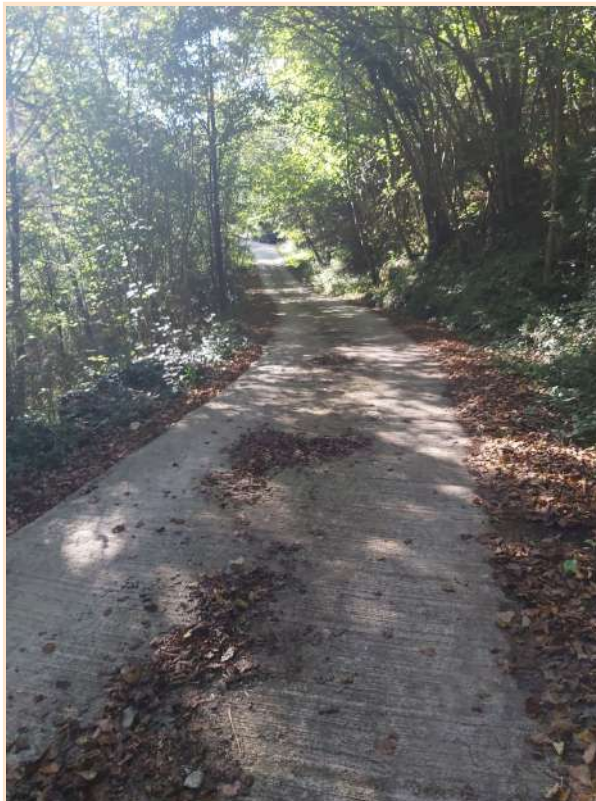
Secció formigonada (cota 857m)
