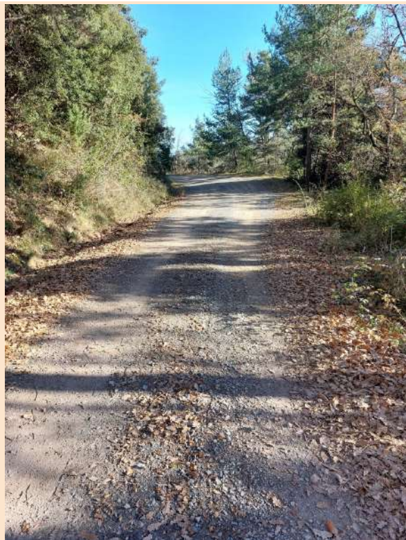
Tram del camí ample, amb tram de terra en bon estat
