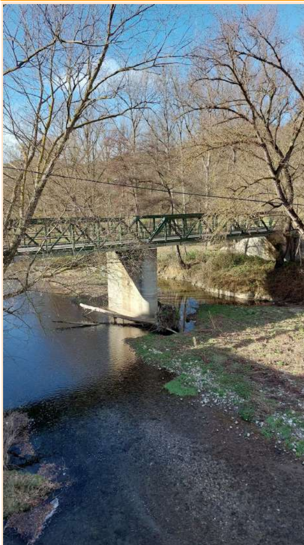
Pont de Cal Gat
