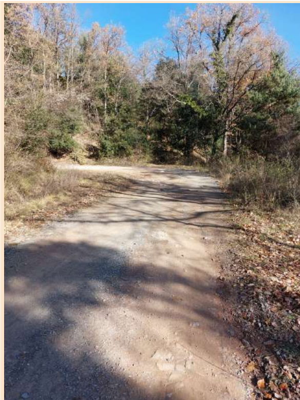
Tram del camí, ample, en ferm de terra, degradat
