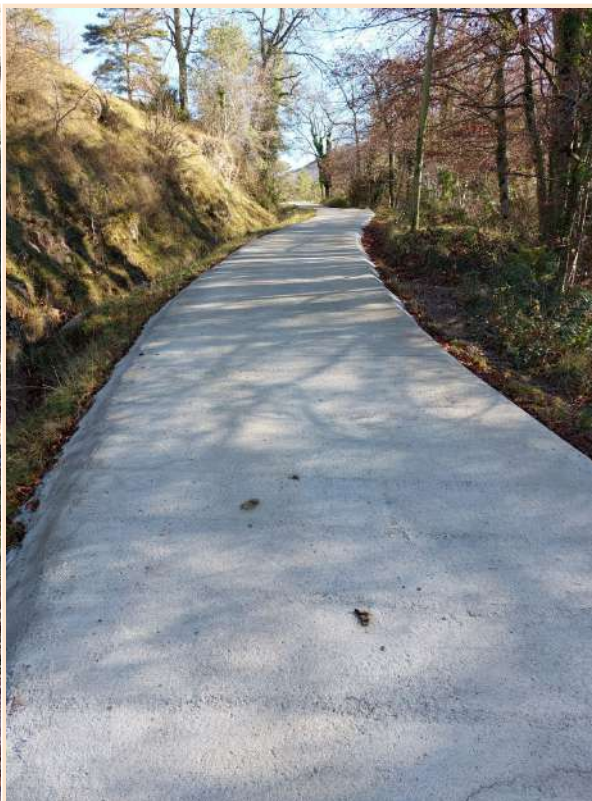
Tram formigonat en bon estat
