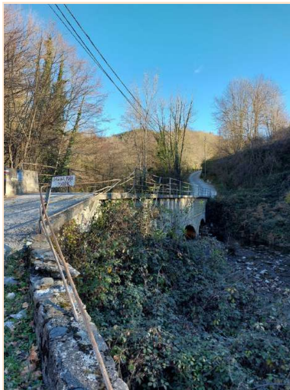
Pont sobre el torrent del coll de Pal
