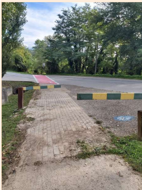
Creuament amb la carretera GIV-5211
