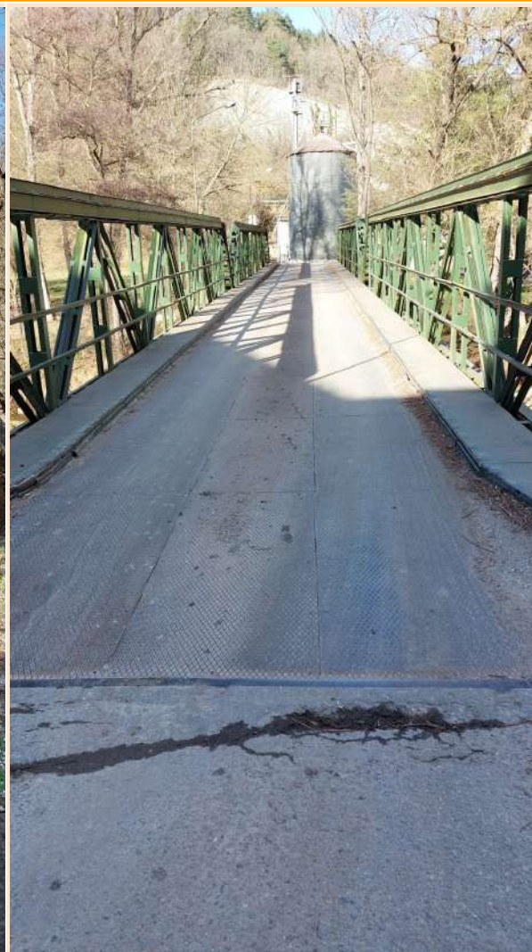
Superfície de rodadura del Pont de Cal Gat
