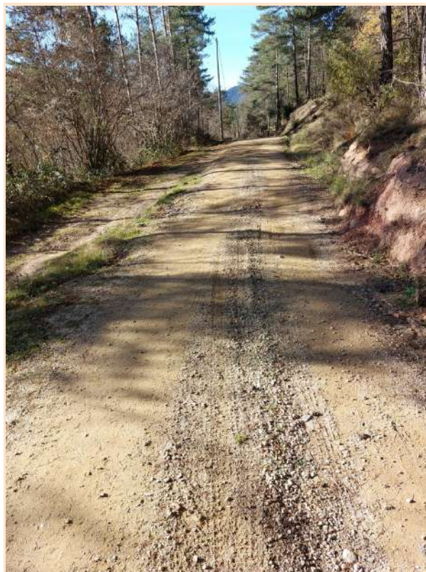
Tram del camí (cota 915m)
