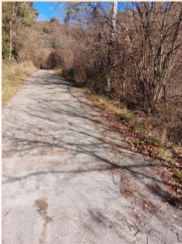
Tram inicial del camí, al pont del Planàs
