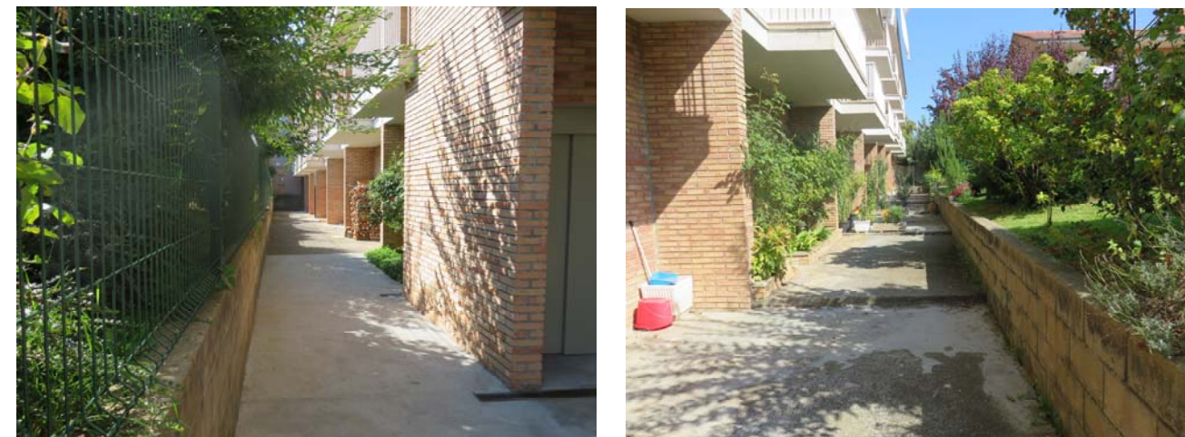
Espai lineal del subàmbit B, qualificat com espai lliure públic, situat a la mateixa cota que la planta baixa dels habitatges unifamiliars que hi confronten, i enfonsat respecte del terreny de la plaça St. Luís de Potosí
