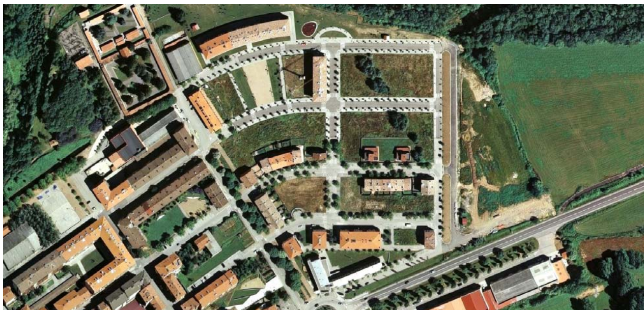
VISTA GENERAL DE L'ÀMBIT
