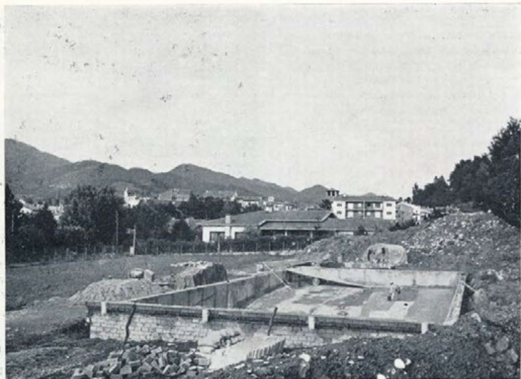
Piscina en construcción en La Plana, primera de las instalaciones que compondrá la Unidad Deportiva Básica,
