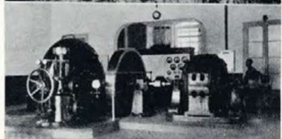
Salt d'aigua i sala de motors de la fàbrica d'electricitat de Fills de Ramon Benet en el mateix any.
