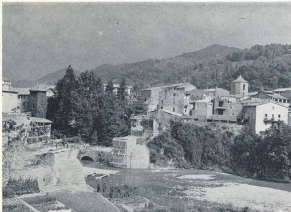
Estado actual de la reconstrucción del «Pont Vell».
