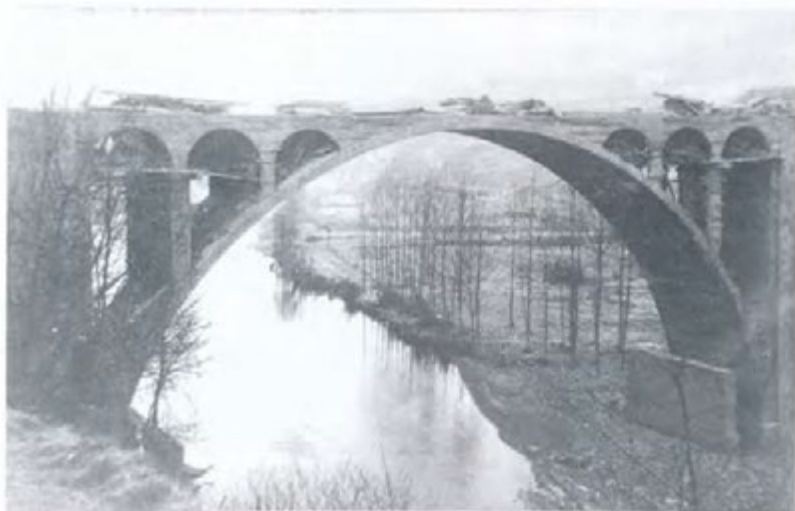
L'arc de formigó armat, acabat. Finals d'octubre de 1919.
