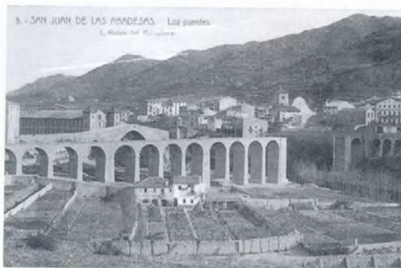
El Pont Nou, sense l'arcada de formigó armat. 1917-1918.
