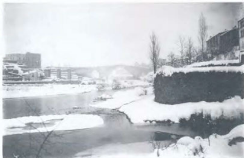
La ribera del riu Ter nevada. Al fons, a l'esquerra, s'aprecien algunes pilastres del Pont Nou, mentre que, al centre, apareixen tímidament els fonaments de més pilastres. Aproximadament, primer terç del 1916.
