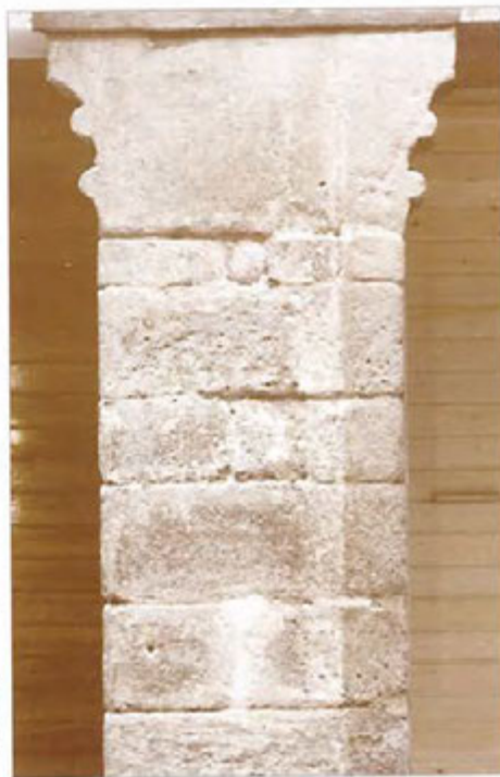
Biga d'un habitatge del carrer de l'Abat de Vilaalba
