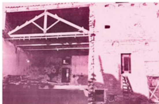
La imatge de les obres de construcció de l'actual Teatre Centre ens permet observar les reduïdes dimensions de l'antiga sala.
